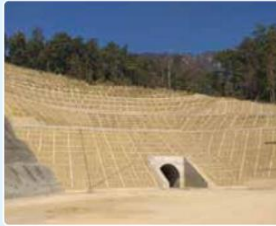
टनेल र स्लोप संरक्षण
