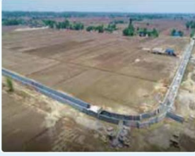
पश्चिम मूल नहर निर्माण बेसलाइन मधुवन नगरपालिका
