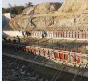
नहर लाइनिङ कार्य टनकपुर मूल नहर
