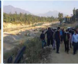
निर्माणाधीन बाँध स्थल
